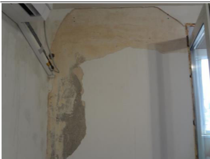
Фотография 3.15. Состояние отделки помещений
