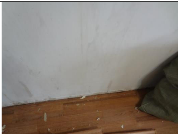
Фотография 3.14. Состояние отделки помещений
