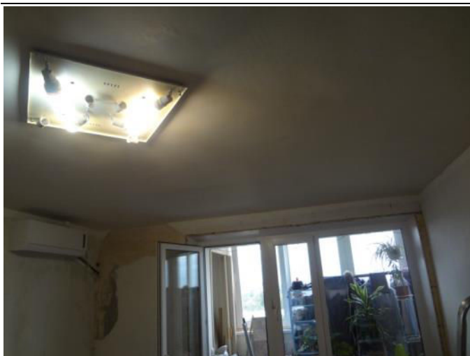
Фотография 3.7. Состояние отделки помещений
