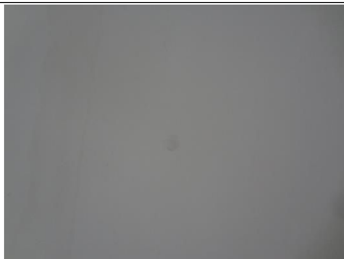
Фотография 3.8. Состояние отделки помещений
