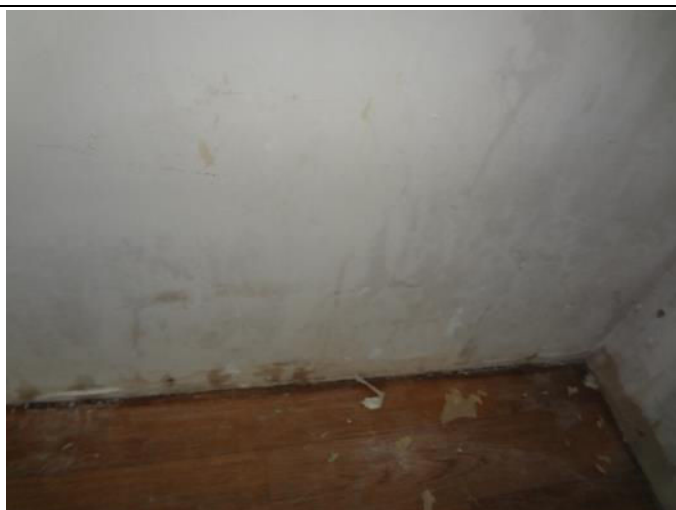
Фотография 3.16. Состояние отделки помещений
