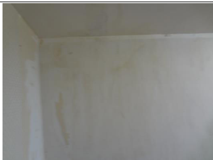
Фотография 3.10. Состояние отделки помещений
