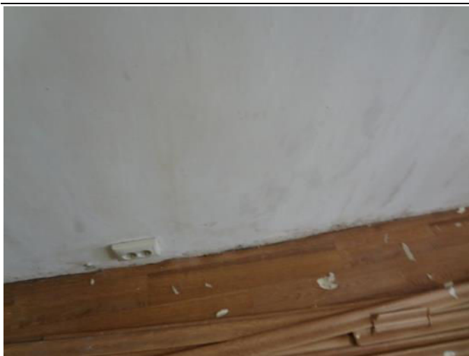
Фотография 3.13. Состояние отделки помещений
