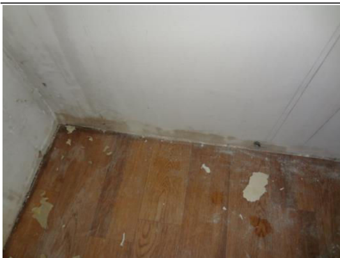
Фотография 3.17. Состояние отделки помещений
