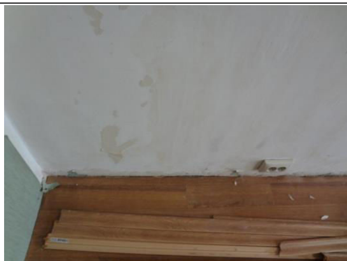
Фотография 3.12. Состояние отделки помещений
